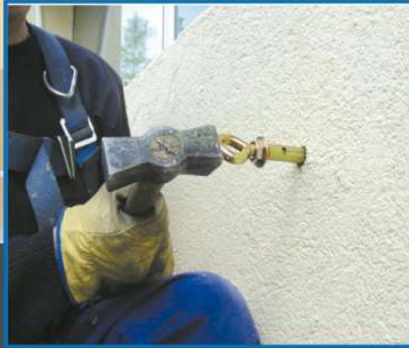
Instalación de perno de fijación
