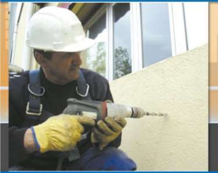
Perforación de muro para colocación de tarugo y perno de fijación
