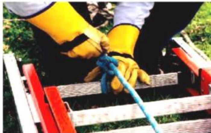
**Antes de iniciar con el armado de escalera;** se instalará un Tie Off, en la parte inferior del poste para la instalación del ~~Gri Gri~~ o sistema de rescate, paralelamente se instalará otro Tie Off, como soporte de línea de vida.
