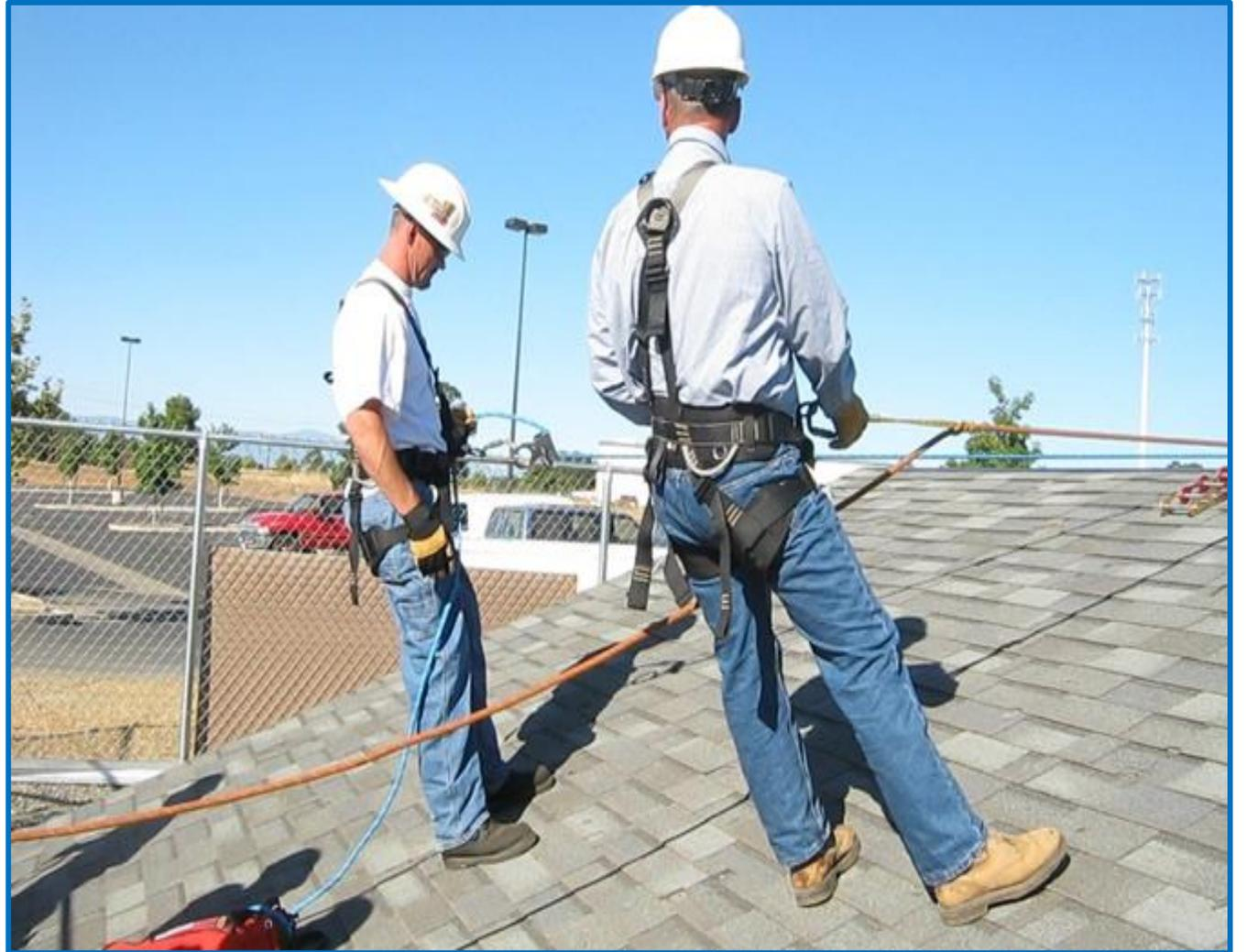
Todas las hebillas y ajustadores deben tolerar una fuerza de tracción de 17.8 kN (4,000 lb.), mientras que todos los anillos “D”, los anillos redondos y los anillos ovalados deben tolerar una fuerza de tracción de 22.2 kN (5,000 lb.).
